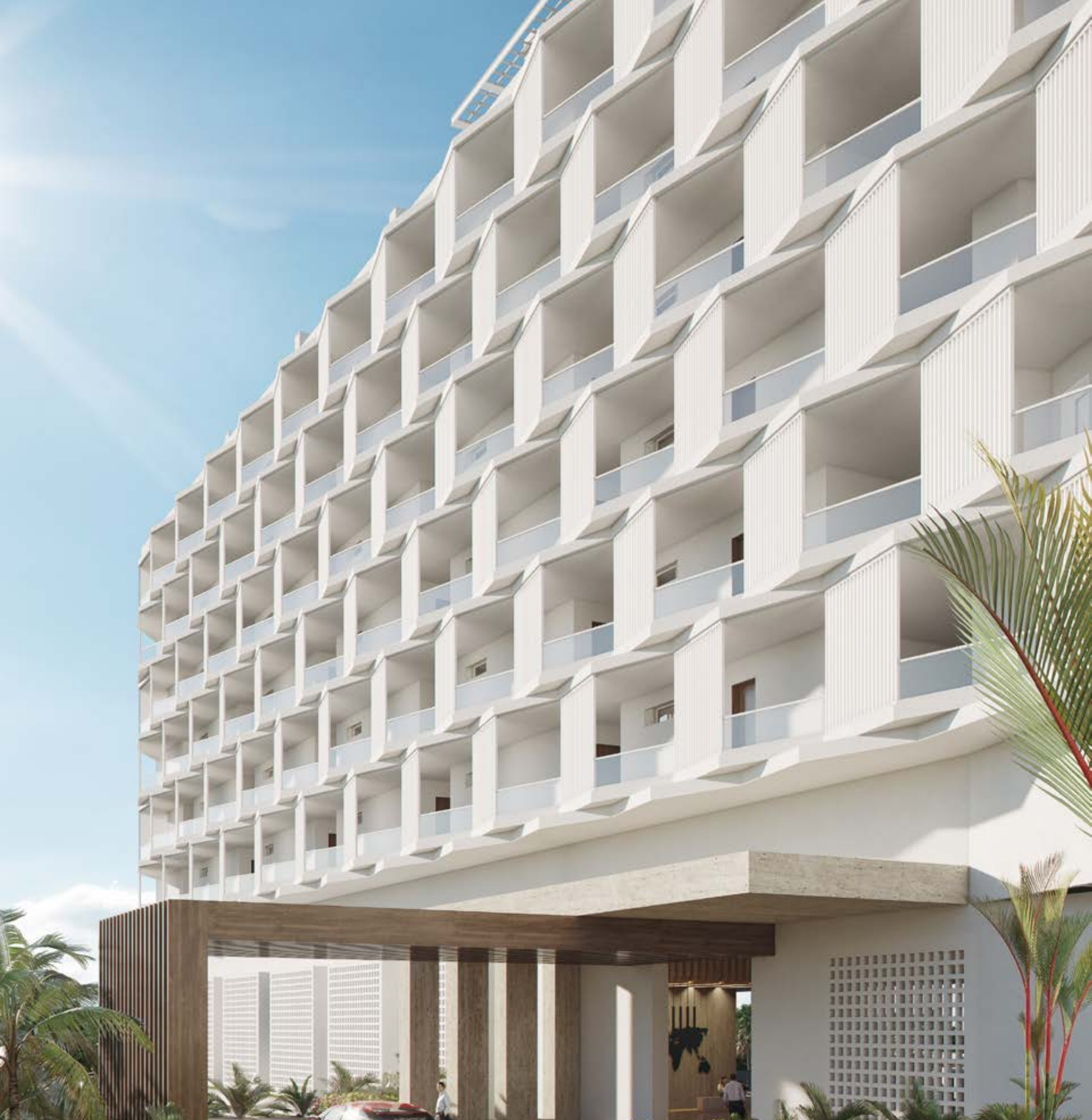
Project / Proyecto : Hotel Portal Astoria
